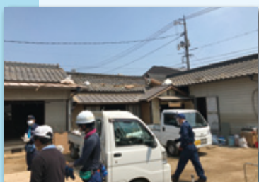
▲被災者宅被害状況(屋根に引っかかったドラム缶)
