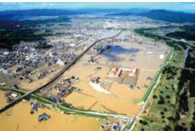
倉敷市真備地区浸水被害状況
